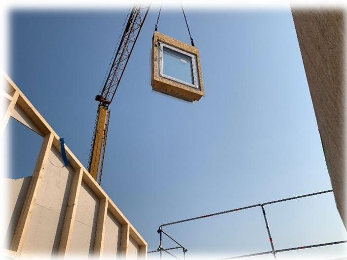
Flexi Woodframe ist ein vorgefertigtes Modul incl. Fenster, zweiter wasserführender Dichtebene, Beschattung, Absturzsicherung, vorverputzter Laibungen mit allen Putzanschlussprofilen rund um das Gewerk Fensteröffnung. Das komplette Modul wird per Kran in der Halle oder auf der Baustelle in die Öffnung eingesetzt und befestigt. Das spart nicht nur enorm viel Zeit in der Fertigung bzw. Montage, vielmehr benötigt man für einen
