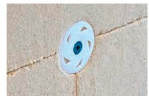
Beim ergänzenden Befestigen mit dem ejothem® S1 Schraubdübel sorgt ein spezielles Tool für oberflächenbündig sitzende Teller.
