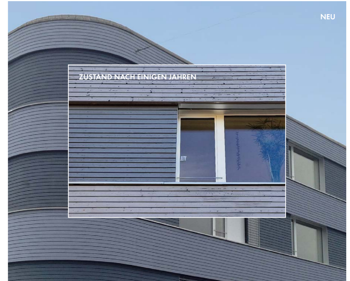
Alterungsprozess einer mit KEIM Lignosil-Artis beschichteten Fassade (Wohn- und Geschäftshaus Winterthur, CH)
