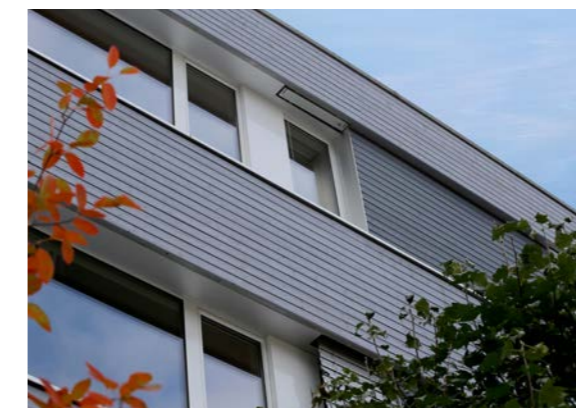
Alterungsprozess einer mit KEIM Lignosil-Artis beschichteten Fassade (Wohn- und Geschäftshaus Winterthur, CH)
