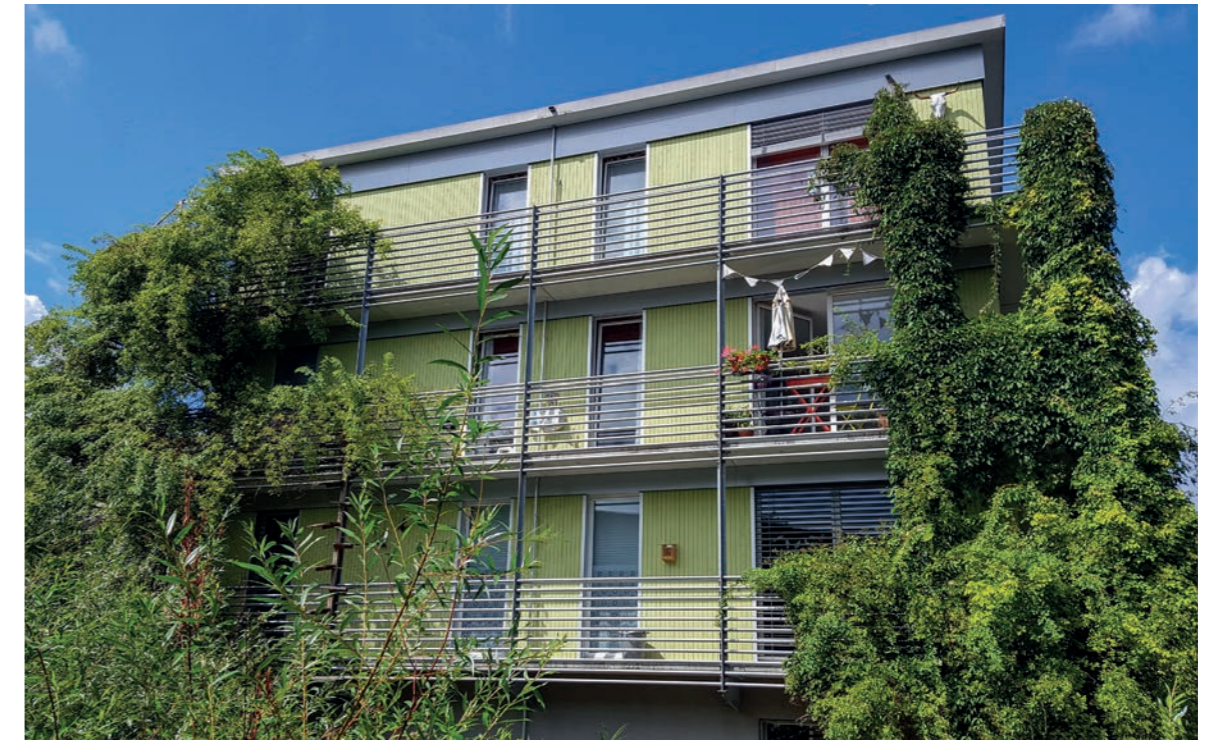
Mehrfamilienhaus, Bockler-Areal, Zürich
