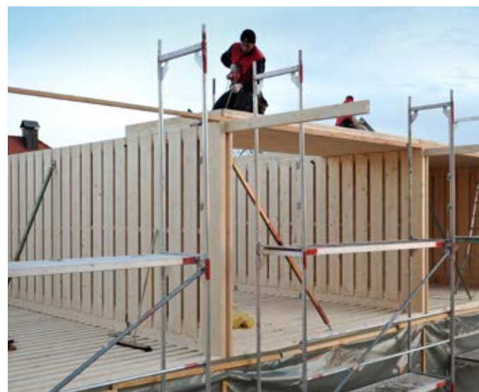
Bild unten: Die Konstruktion im Rohbau. Die Rippenstruktur der LIGNO Uni Q3-Wandelemente ist gut zu erkennen.
