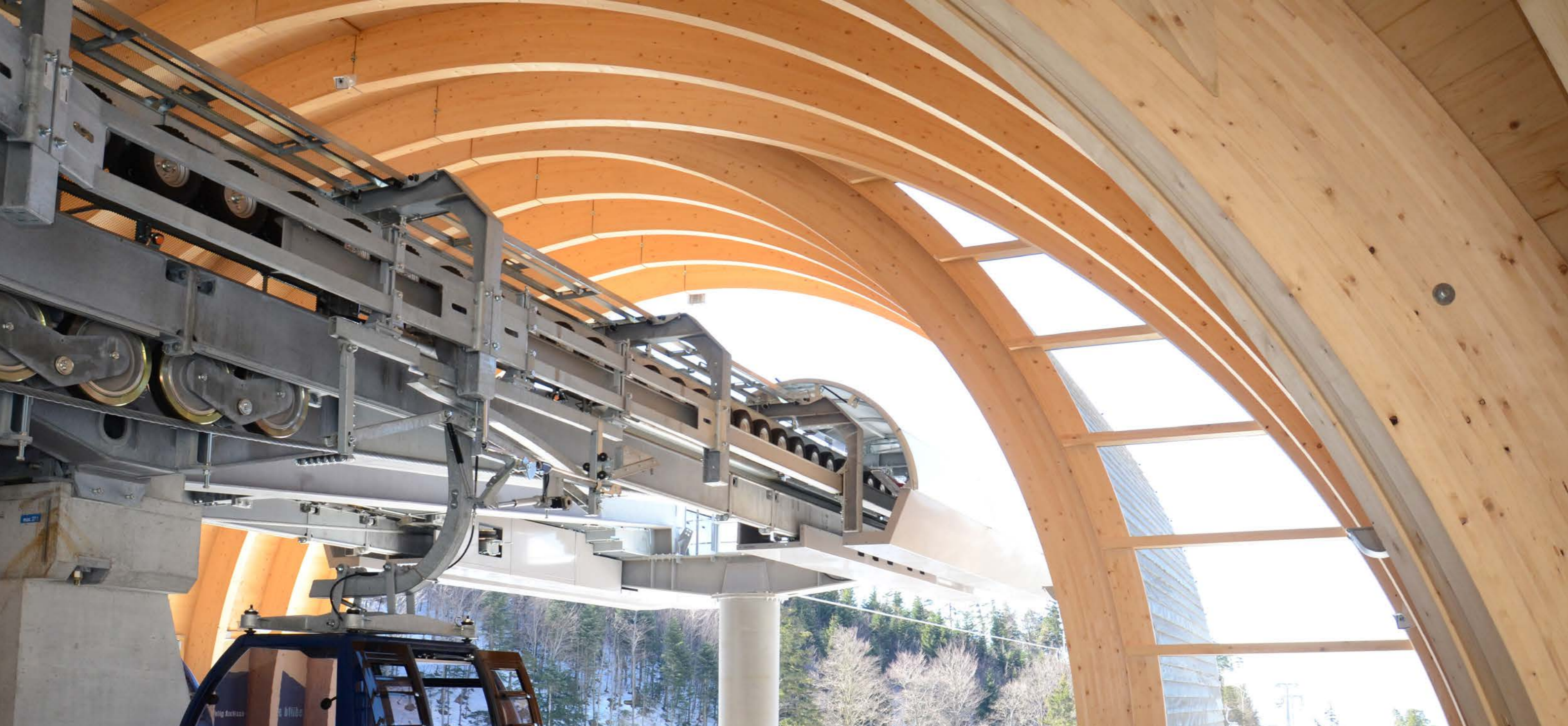
Seilbahn Weissenstein: neue Holzbau AG, Lungern
