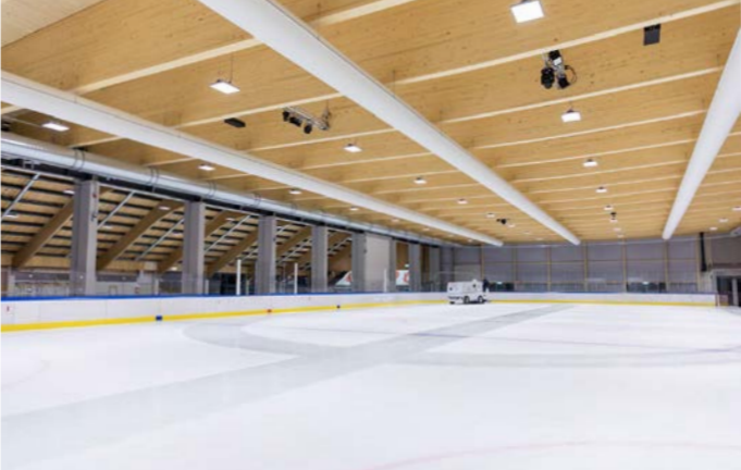
Eishalle Villingen-Schwenningen, Holzbau Amann GmbH
