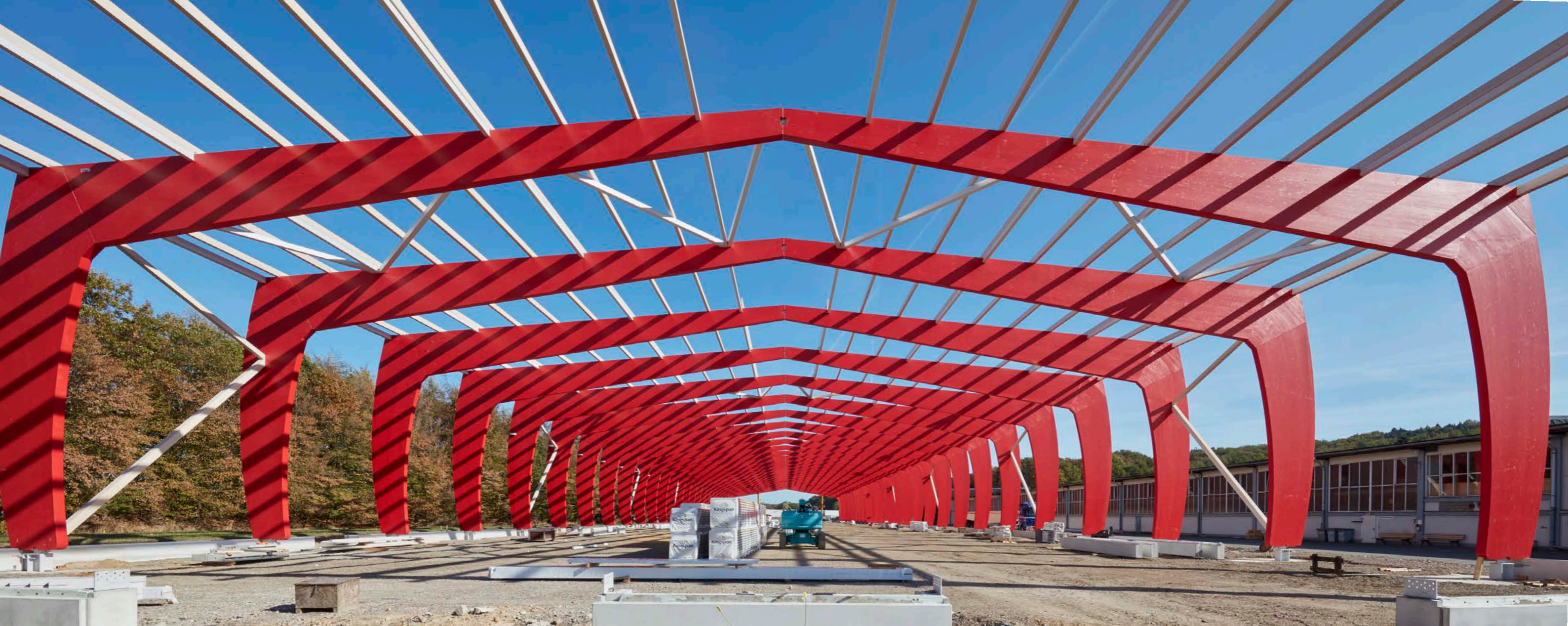
Neubau X-LAM Produktionshalle, Derix LIGNOPRO® 840 BSH-Varnish RAL 3001
