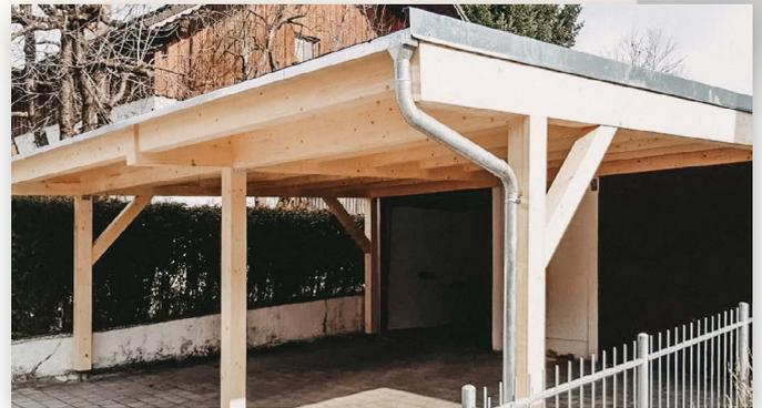
Mithilfe der **Paneltwistec Schrauben** und **KonstruX ST Vollgewindeschrauben** aus dem Produktsortiment von Eurotec kann der EckTec-Verbinder unter Berücksichtigung entsprechender statischer Vorbemessungen an die Konstruktion montiert werden.
