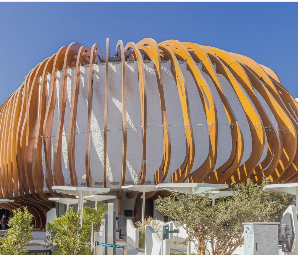
von Bäumen und Sträuchern eingeraht, welche die Holzkonstruktion der Fassade zusätzlich mit Leben erfüllen. Die strukturelle Herausforderung bei diesem Projekt bestand in der geometrischen Komplexität der Verkleidung sowie der Schnittstellenformung zur tragenden Stah-
