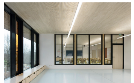
Die Betreuungsräume sind jeweils zwischen zwei Klassenräumen platziert. Statt einer geschlossenen Wand ermöglichen hier geschosshohe Festverglasungen den Blickkontakt in die Klassenzimmer. Dies macht es den Lehrkräften einfacher, sowohl Schulklasse als auch Betreuungsgruppe zeitgleich zu beaufsichtigen.
