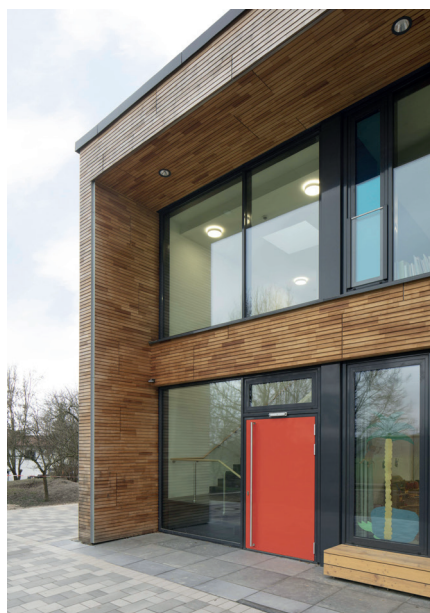
Die geschlossenen Bereiche der Fassade bestehen aus Elementen Ligno Fassade mit einer unbehandelten horizontalen Lattung aus Lärchenholz.
