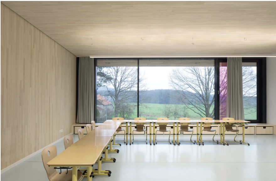
Besonders schön ist der Übergang zwischen Holzwand und Holzdecke gestaltet. Schmale Schattenfugen am Übergang zu den Deckenflächen erwecken den Eindruck, als würden diese über den Räumen schweben.
