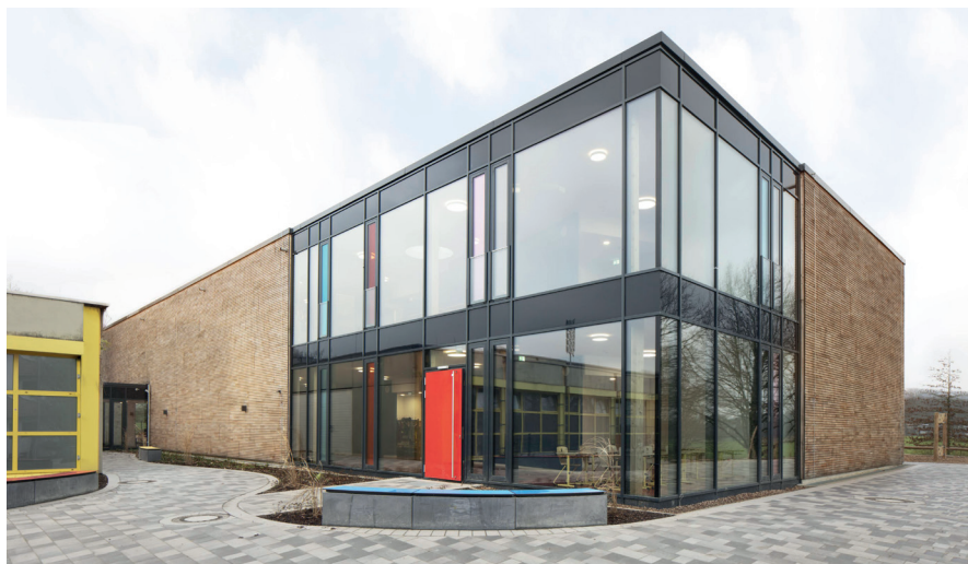
Die Erweiterung der Städtischen Grundschule Obering ist ein naturgesunder Holzbau aus Brettsperrholz-Rippenelementen für Wand, Decken und Dach. Die vollverglaste Gebäudeecke markiert den repräsentativen Eingang ins neue Schulhaus.
