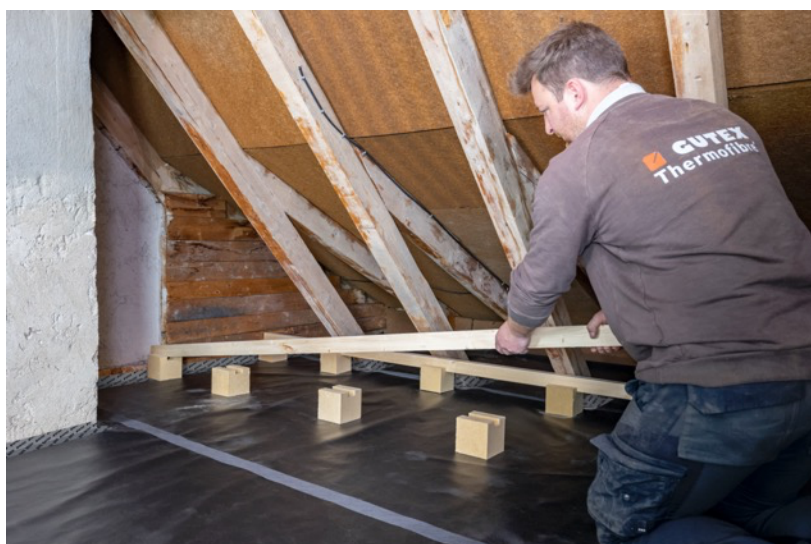
Die GUTEX Stamp Dämmfüße sind das wärmebrückenfreie Fundament des Dämmsystems. Foto: Martin Granacher
