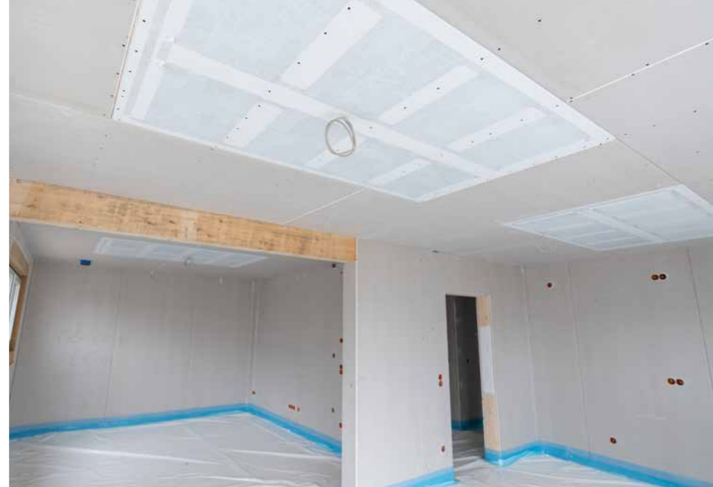
thermoheld ·WAND· im Einsatz als Deckenheizung
