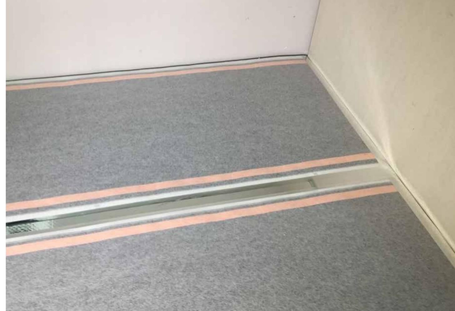
thermoheld ·BODEN· bei der Montage im Wohnbereich
