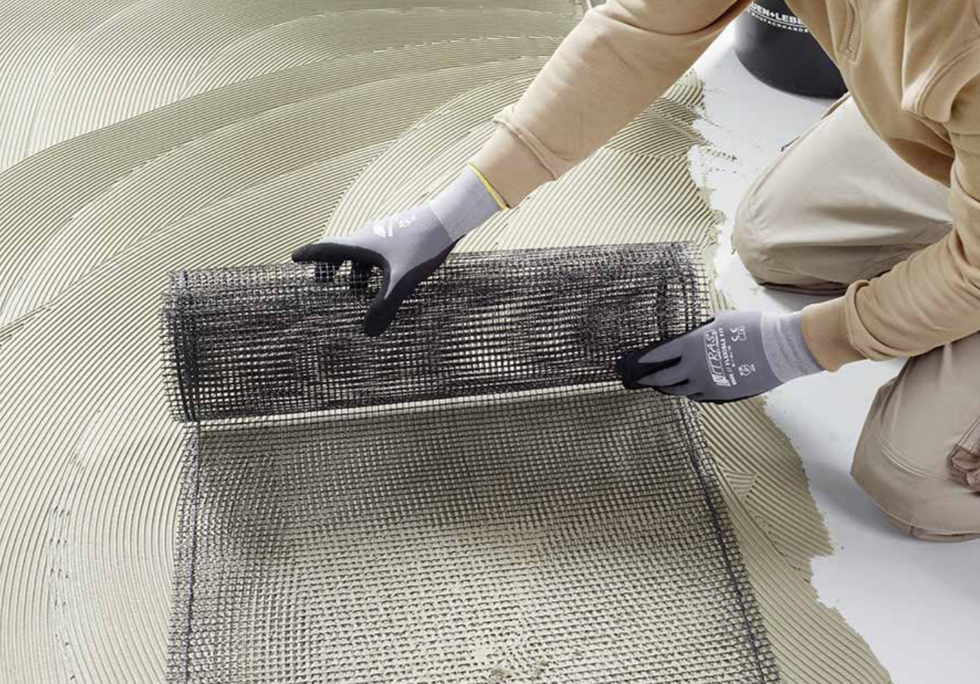
thermoheld ·FLIESE· beim Einbau im Badezimmer
