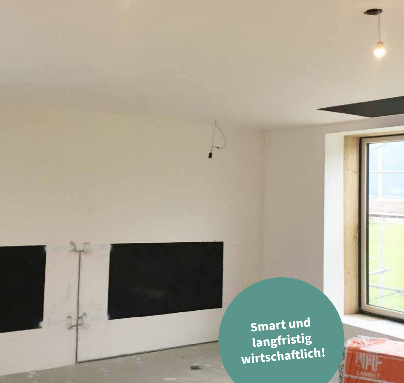
Im Decken- und Wandbereich sind die thermoheld Produkte hier optimal eingesetzt
