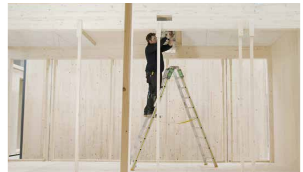
Installation der technischen Gebäudeausrüstung.
