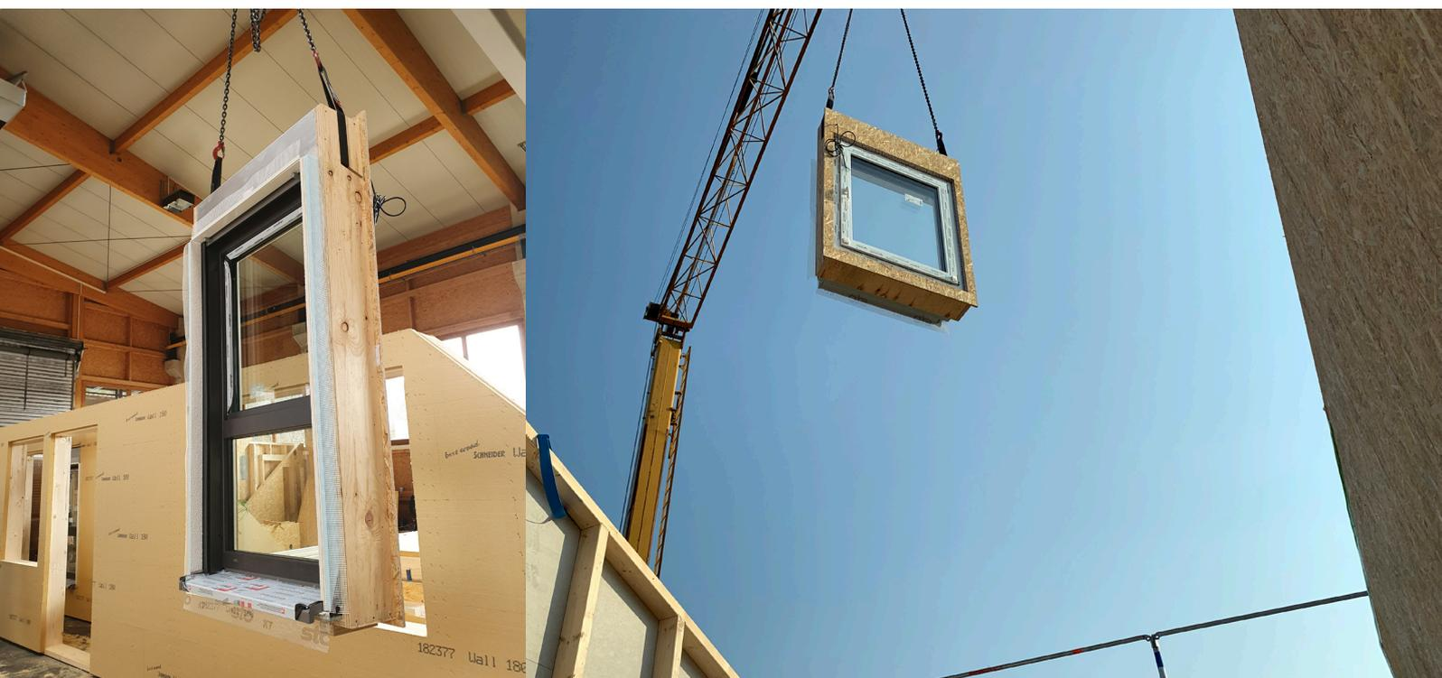
Eine fachgerechte Montage der Module wird nicht dem Zufall überlassen, sondern wird von Beginn an bis ins Detail geplant. Die Elemente können direkt in der Wandfertigung oder auch auf der Baustelle montiert werden. Für beide Situationen haben wir die perfekte Lösung.
