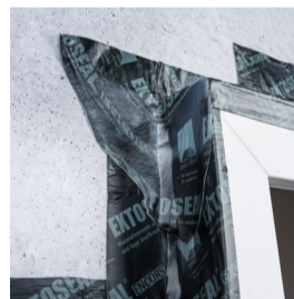
Anschluss von Fenstern im Mauerwerk- und Betonbau.
