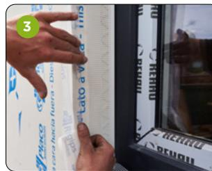
**Mit dem Abdichten der Rigips Glasroc X Gipsplatten an allen notwendigen Fugen- und Ecken ist ein wind- und schlagregendichter Außenwandverschluss bis zu einer Freibewitterungszeit von drei Monaten gemäß ETA-21/0179 gewährleistet.**
